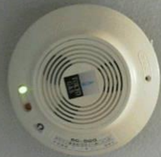
ガス漏れ検知器 室
